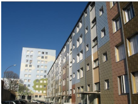
Avant (tour et bâtiment Caffort)
